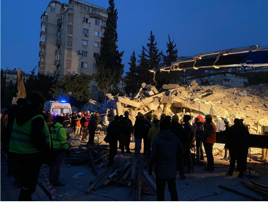
Şekil 2 – Güçlendirilmiş Binanın 6 Şubat Depremleri Sonrası Görüntüsü
